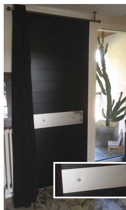
Fixation bâtons de tirage côté intérieur - Inserts visibles
